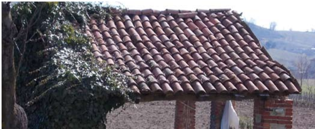
Manti di copertura tradizionali
